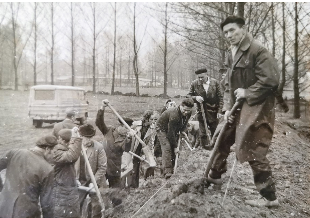
Budowa boiska. Fot. ze zbiorów rodzinnych Ewy Tutkaj
