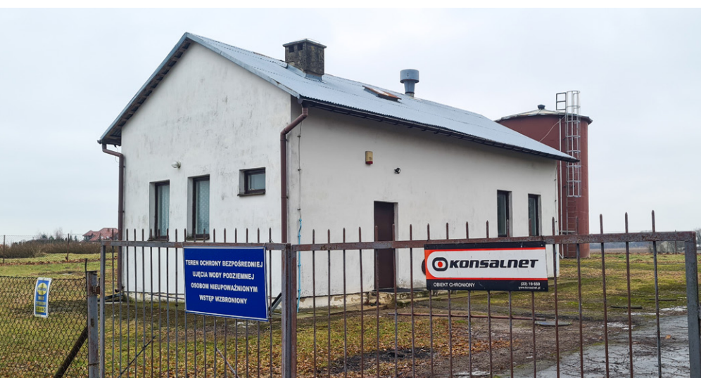
Stare ujęcie wody w Klementowicach Fot. Gmina Kurów
