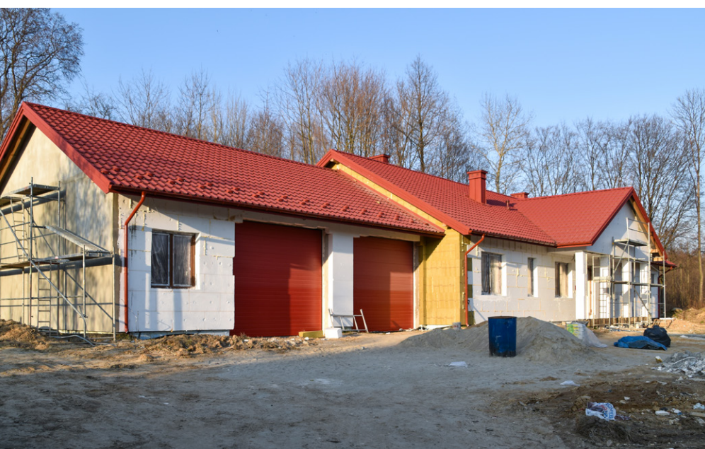
Budowa strażnico-świetlicy w Klementowicach Fot. Gmina Kurów
