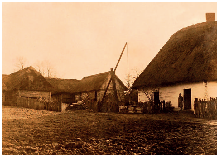
Zabudowa wsi, początek XX w.
