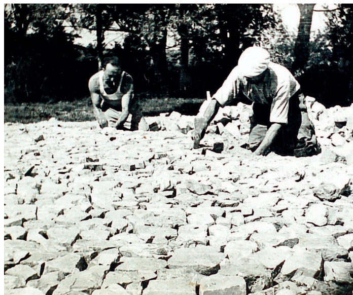
Budowa drogi do Buchałowic
