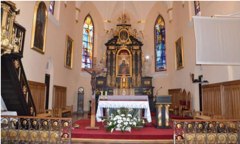
Kościół parafialny w Klementowicach. Prezbiterium po renowacji /2013 r./
