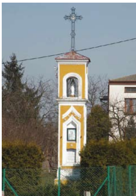
Kapliczka murowana słupowa przy skrzyżowaniu ul. Kościuszki i Głębokiej w Kurowie /2009 r./
