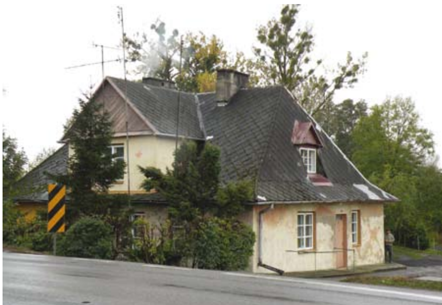
Budynek „łazienki” w Kurowie z okresu międzywojennego /2009 r./
