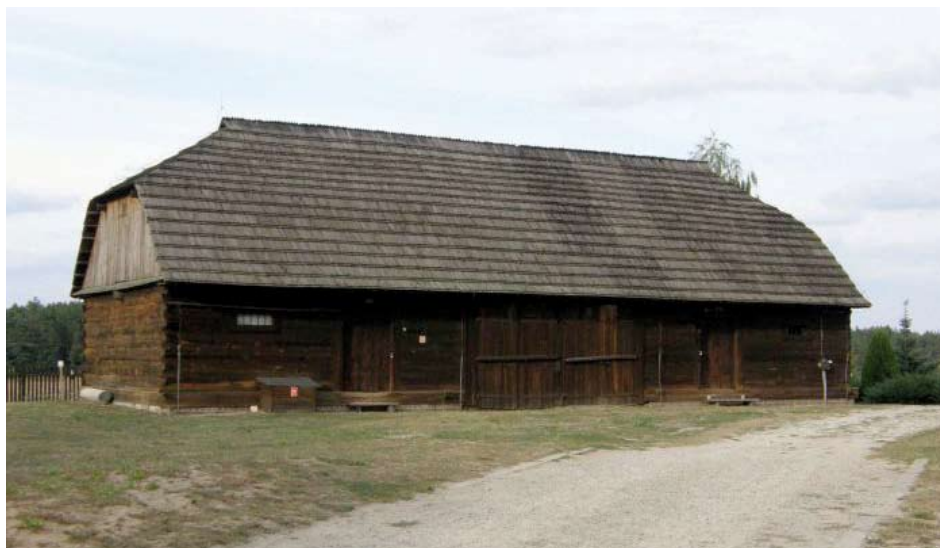
Spichlerz z Kurowa drewniany na podmurówce, na planie wydłużonego prostokąta, jednokondygnacyjny, dach naczółkowy kryty gontem, przełom XIX-XX w.
