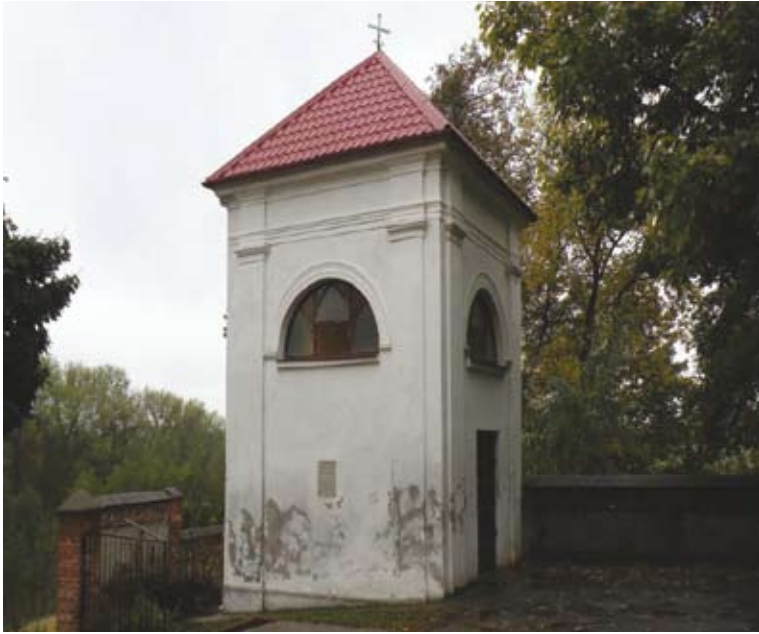
Zespół kościelny w Klementowicach. Dzwonnica /2009 r./
