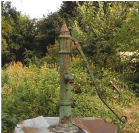
Studnia na pompę ul. Kowalska w Kurowie /2009 r./
