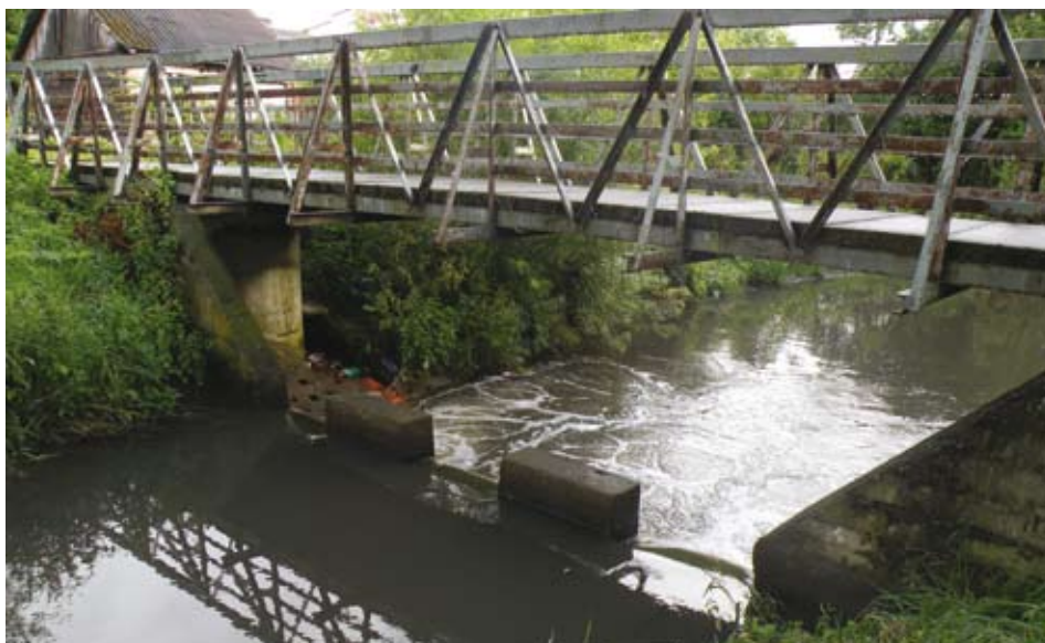
Kładka metalowa na rzece Kurówka z lat siedemdziesiątych XX w. /2011 r./
