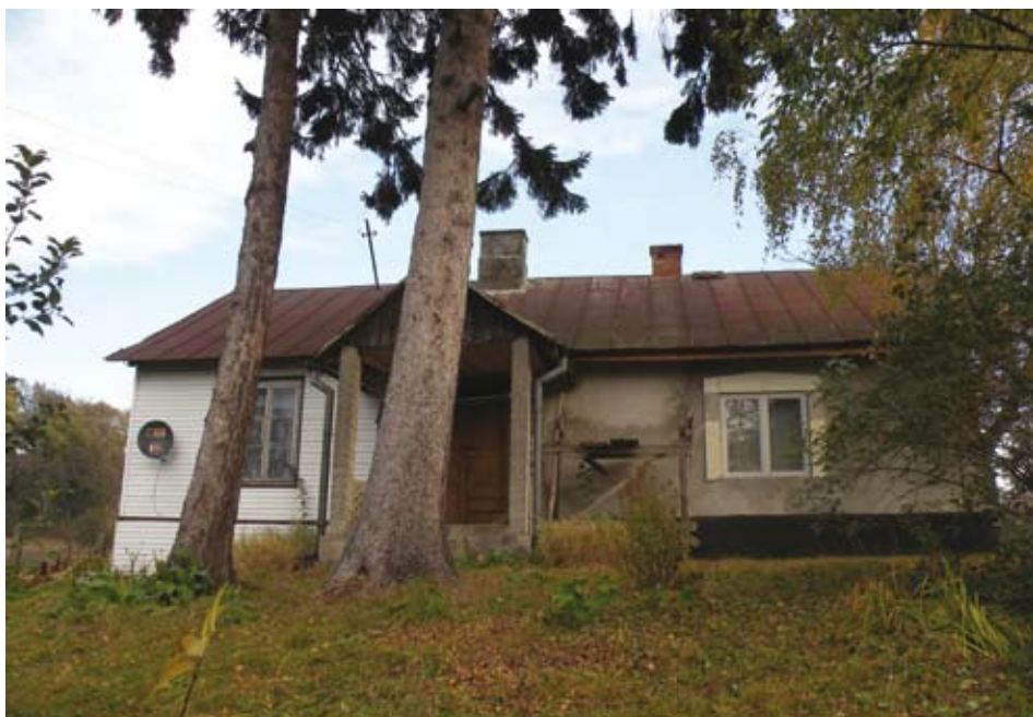
Budynek szkoły w Klementowicach z 1900r./2011 r./
